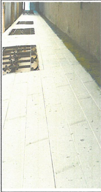
Foto 5: Exterior de muro de aula a pintar.
